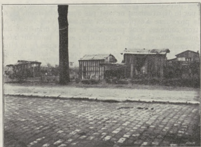
LA COURNEUVE : Aspect du lotissement l'Avenir.
